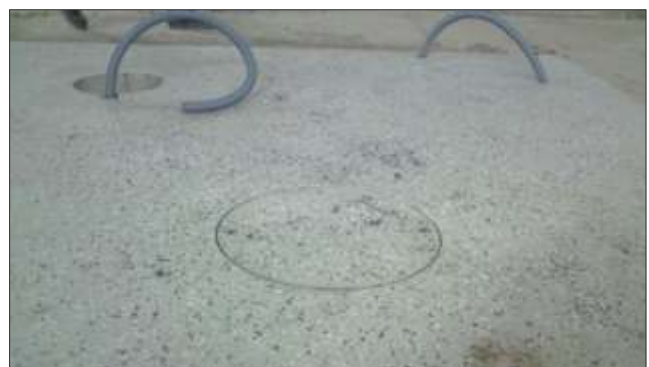
das Auflegen der Bodenplatte zur GOLDGRUBE®/BB-Br ↑
