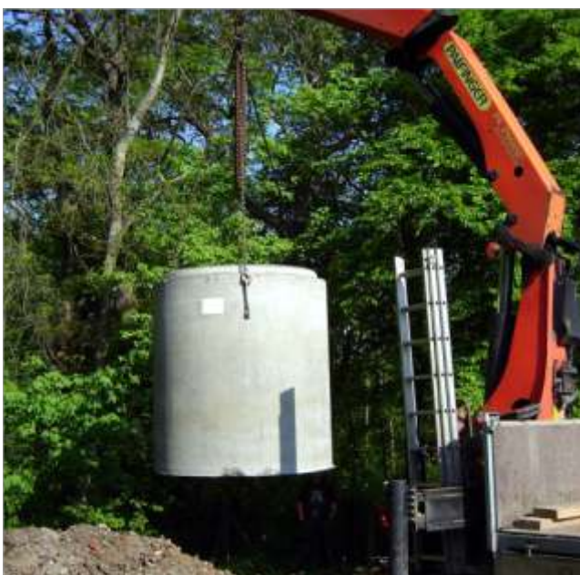
↑ Setzen des Basisbehälters vom Liefer-LKW
