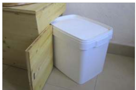
Seitliche Entnahme des Fäzes-Sammelbehälters
